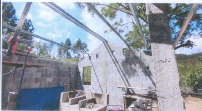
Foto 1: Instalación de techo pórtico.
