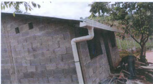
Foto 3: Vista frontal de la instalación de bajada de agua pluvial.
