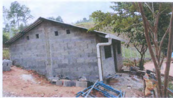
Foto 2: Instalación de bajada de agua pluvial.
