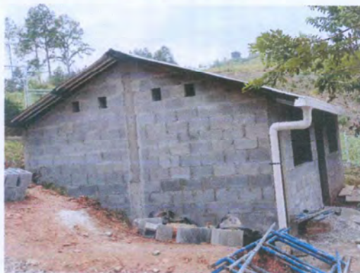
Foto 4: Se continúa la colocación de 7.3 metros lineales de canal.
