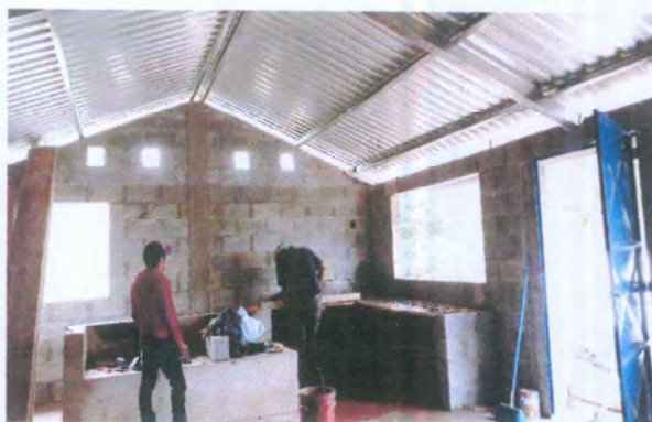
Foto 3: Instalación de banco de trabajo.
