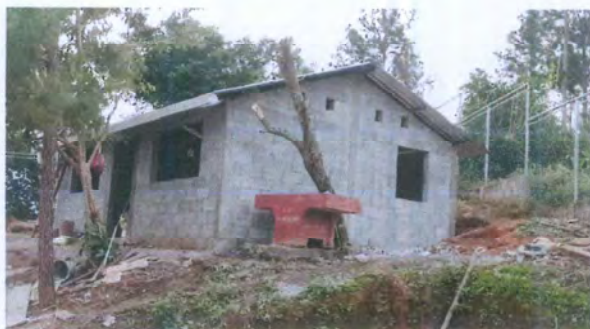
Foto 1: Instalación de canal de agua pluvial
